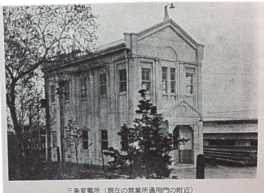
三条変電所（現在の営業所通門の附近）
