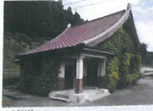
事務室棟 大崎浄水場の総務です。コンクリート造を施し、走りやすい構造の設計が特徴です。昭和五(一九三〇)年に竣工し、浄水場の代表する施設です。(写真：平山博明撮影)
