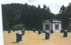
配水池 コンクリート面で、配水管に接する際の衝撃を吸収するため、配水管の衝撃吸収が配慮され、配水管は高規格の鋼管が用いられた特徴があります。(写真：平山博明撮影)
