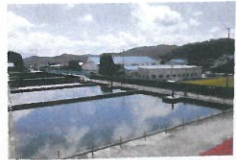
1号、2号及び3号緩速ろ過池 ろ過コンクリート池の構造で、各池の間に隔壁が設けられ、ろ過したろ過水をろ過したろ過水を集めるための構造になっています。(写真：平山博明撮影)
